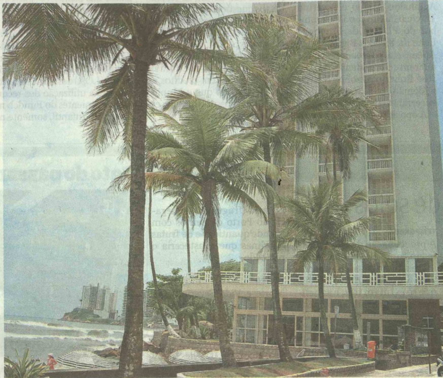
Prédio tem arquitetura modernista e foi feito usando a pedra como base, o que permitiu dispensar a fundação
